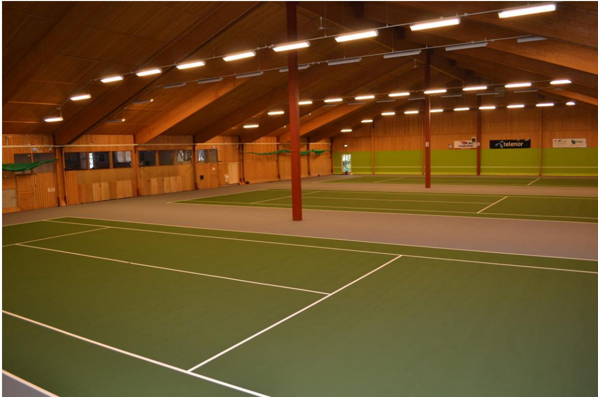
Nytt banedekke (Plexipave) ble lagt i hallen sommeren 2016
